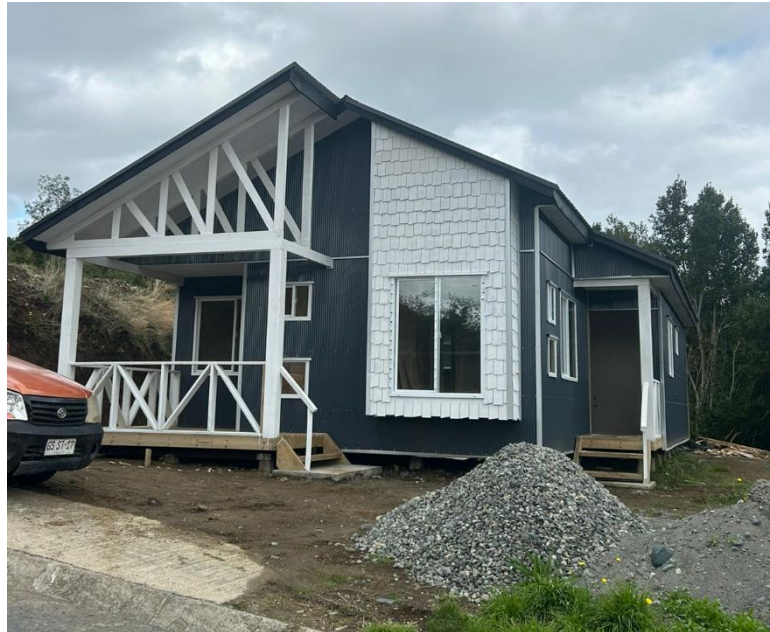
Vivienda rural DS-10 en construcción.
