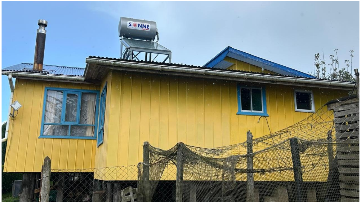
Termo colectores instalados.
