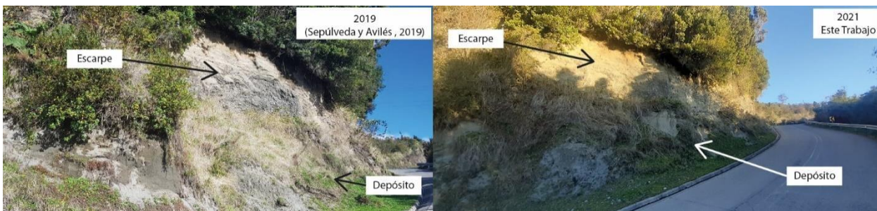
Figura 4. Comparación de fotos del 2019 y 2021 de escarpe con remoción en masa inactiva, cubierta por vegetación, al menos desde el 2019 (foto del 2019 tomada de Sepúlveda y Avilés, 2019)
